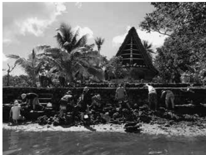
石垣の補修作業
