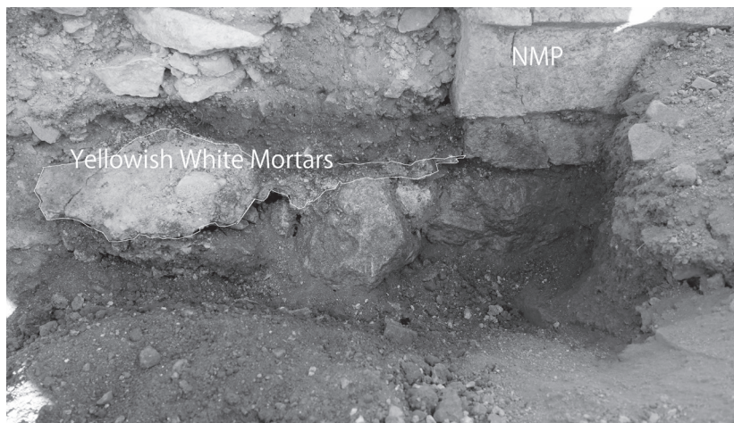
写真 28 北大黒柱の基礎と黄白モルタル層 (左手では手前に垂れ下がっている)
