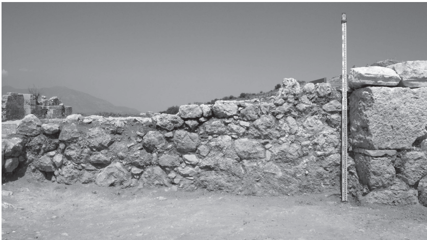
写真8 南西第1室東側壁(東→西)
