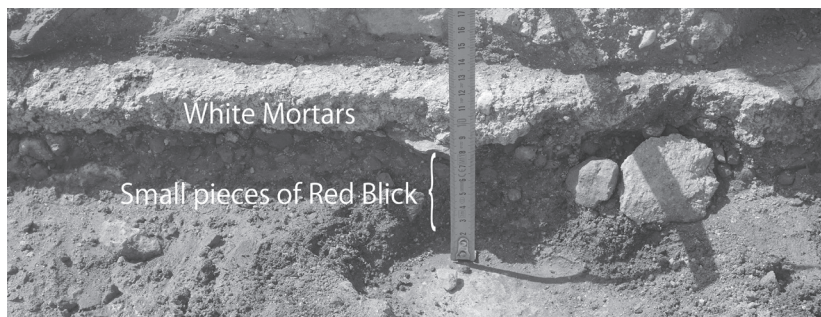
写真 27 身廊のモザイク床の断面
