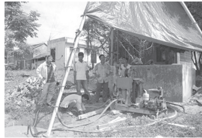
井戸掘削の作業
