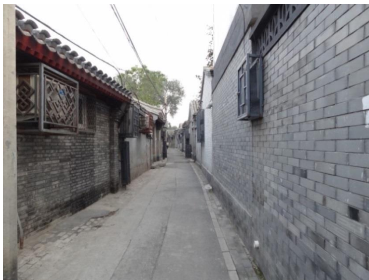
写真 3.9 改修された小金糸胡同
