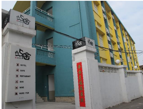
写真 4.5 工場の改造例
