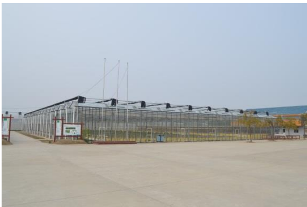
写真2-2 前衛村におけるイチゴ栽培温室
