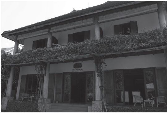
写真3 サラー・パバーンの外観1
