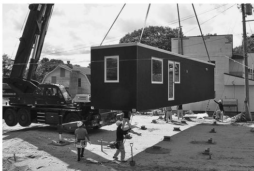
図表 31 安平町の酪農家宅に2棟連結のムービングハウスを設置中(アーキビジョン21提供)
