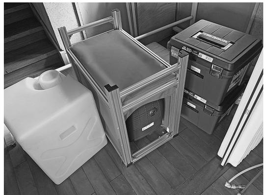
図表 14 令和元年台風 19 号被災の多古町で使用された可搬型LPガス発電機（著者撮影）
