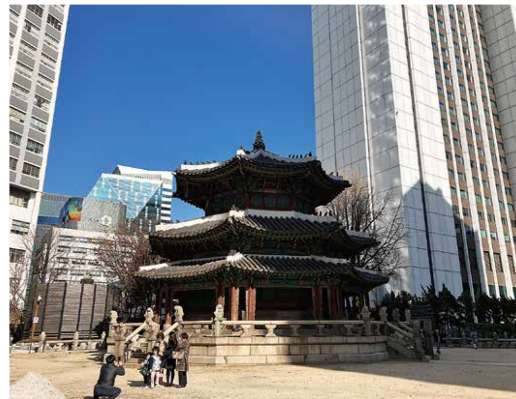
写真4／大韓帝国期に建てられた「皇穹宇」、右奥はウェスティン朝鮮ホテル。「皇穹宇」は、天子が天に祭祀を行う施設として建てられた環球壇で、神位を祀る建物。祭祀を行う中心建物は南側にあったが、1914年、朝鮮鉄道ホテル(ウェスティン朝鮮ホテルの前身)を建立する際に撤去され、現在は皇穹宇だけが残るようになった。
