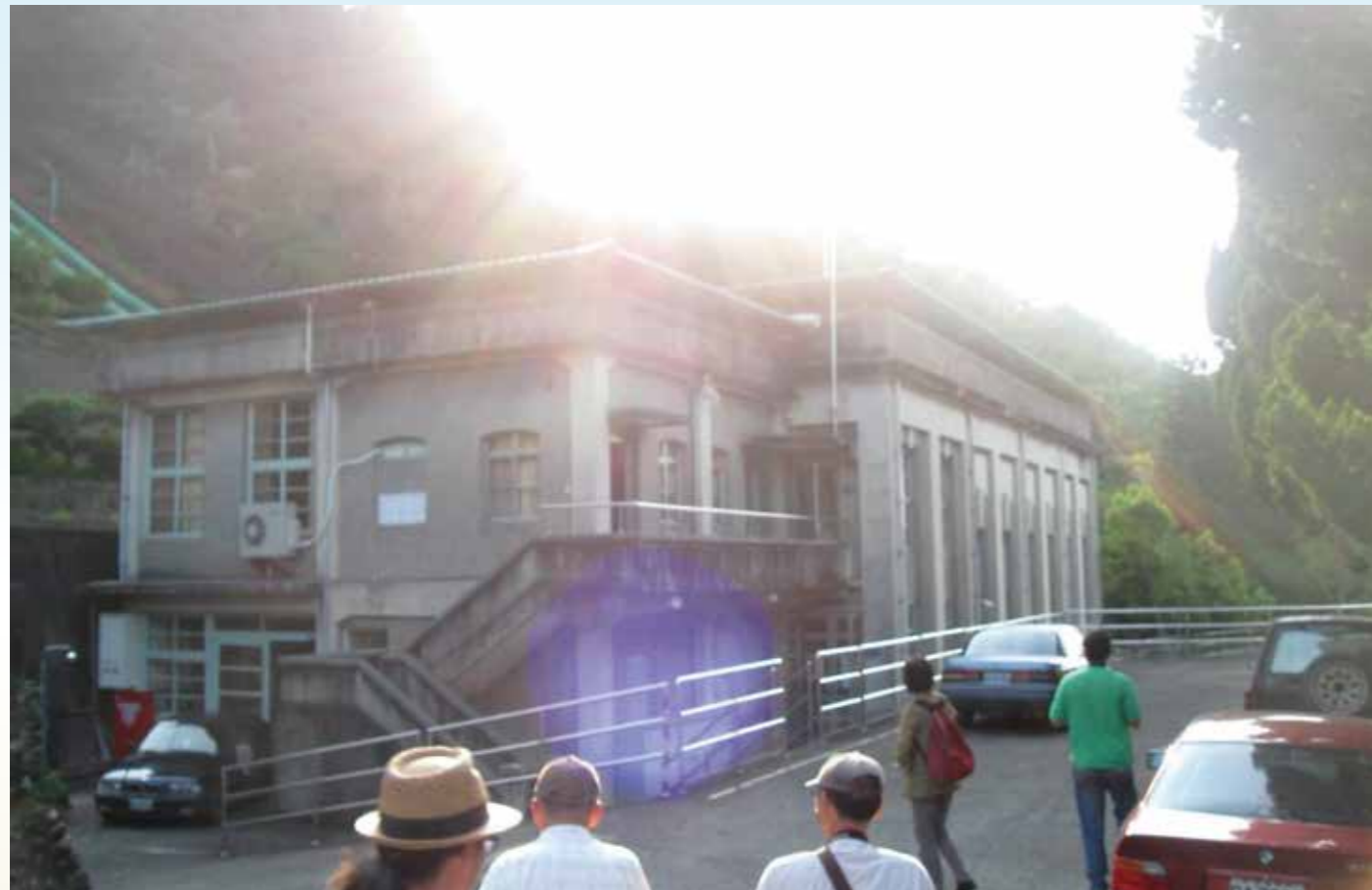
写真1A / 后里発電所。台湾電力公司 OB 林炳炎氏の案内で訪れた。台湾で一番古い現役の発電所
