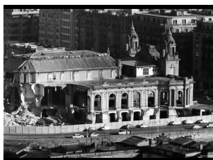
図 2 解体中のクルサール映画館(図 3 とともに数ショットある内の 2 ショット)
