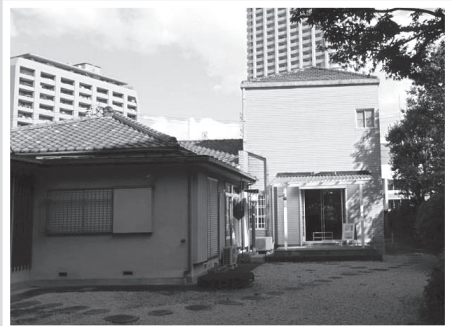
写真三…現状の洋館と主屋を庭から見る
