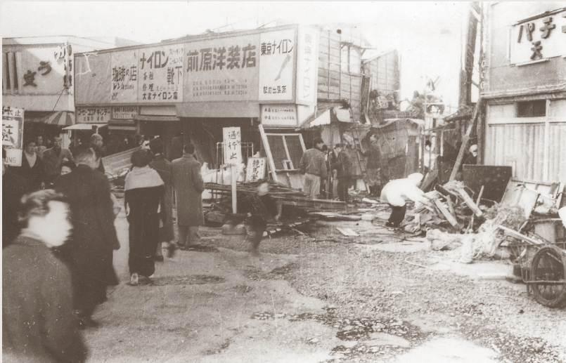
1962年 池袋西口マーケットの取壊し
