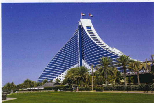
写真3 ジュメイラ・ビーチ・ホテル
