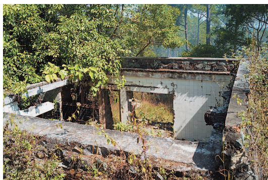
写真5 Chalet d'Etatの地下部分。Kiriromの建築物は他の人民社会主義共同体統治下の建物と異なり木造が主体であった。このため現存する部分はごくわずかで、Chalet d'Etatもコンクリートもしくは石造りの地下部分、煙突のみがかろうじて現存し、それ以外は失われている。地域全体でも現像する遺構はきわめて少数である。
