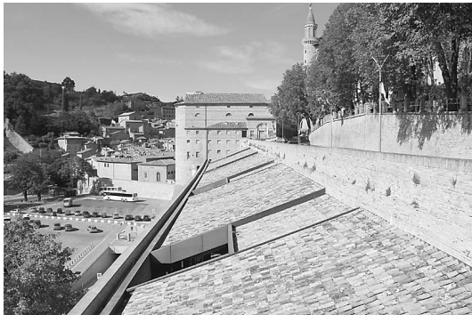
写真4 設計変更されたDataの屋根（2011年9月筆者撮影）。
