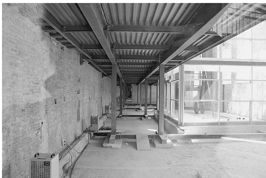
写真6 Data内部の鉄骨構造の地下部分（2011年9月筆者撮影）。
