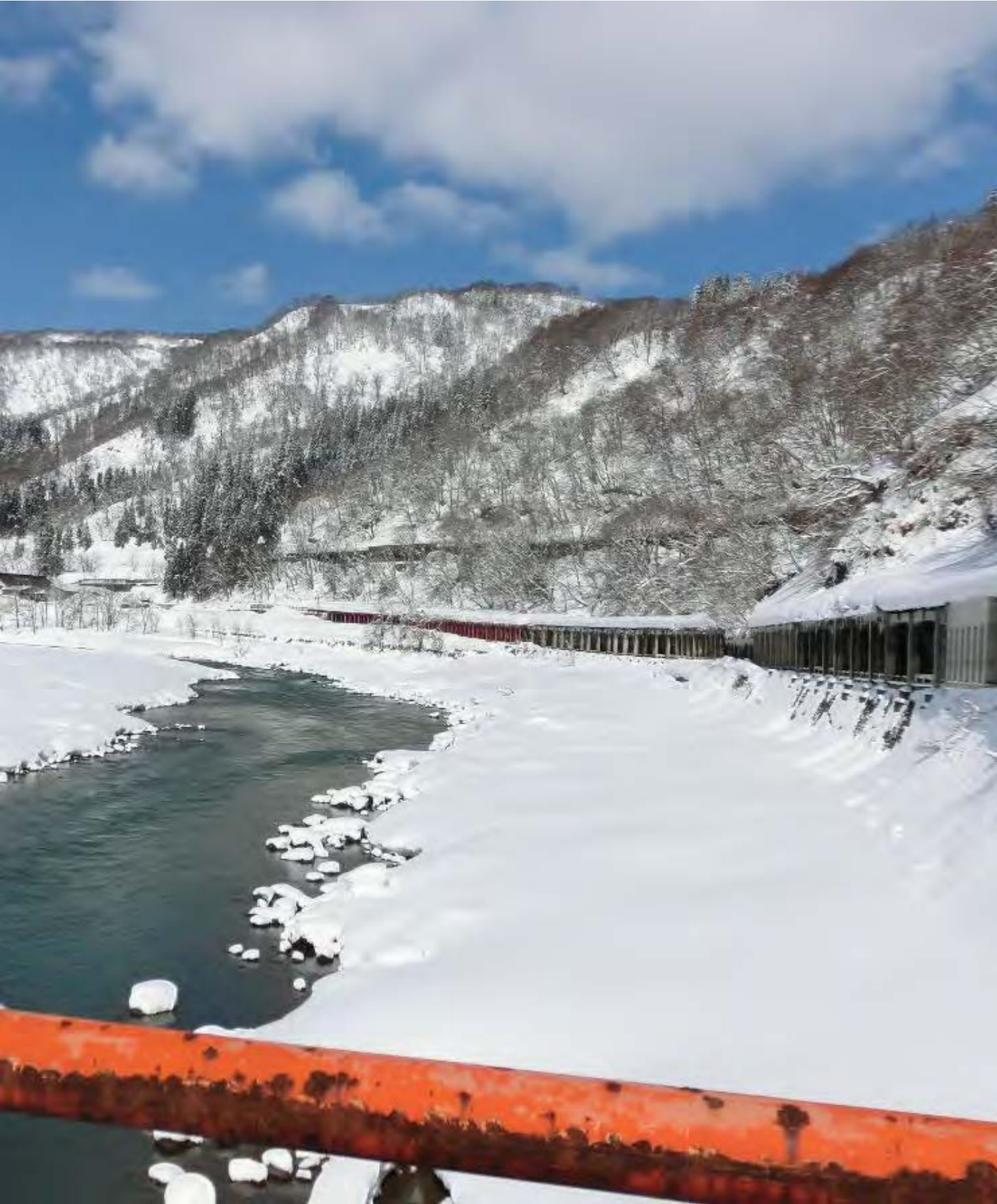
写真1：箕作地区国道407号線から見渡す千曲川とJR飯山線。地震の影響で線路が崩落したが、現在は見事に復旧した。 (写真1・2：荒井美智江 撮影)
