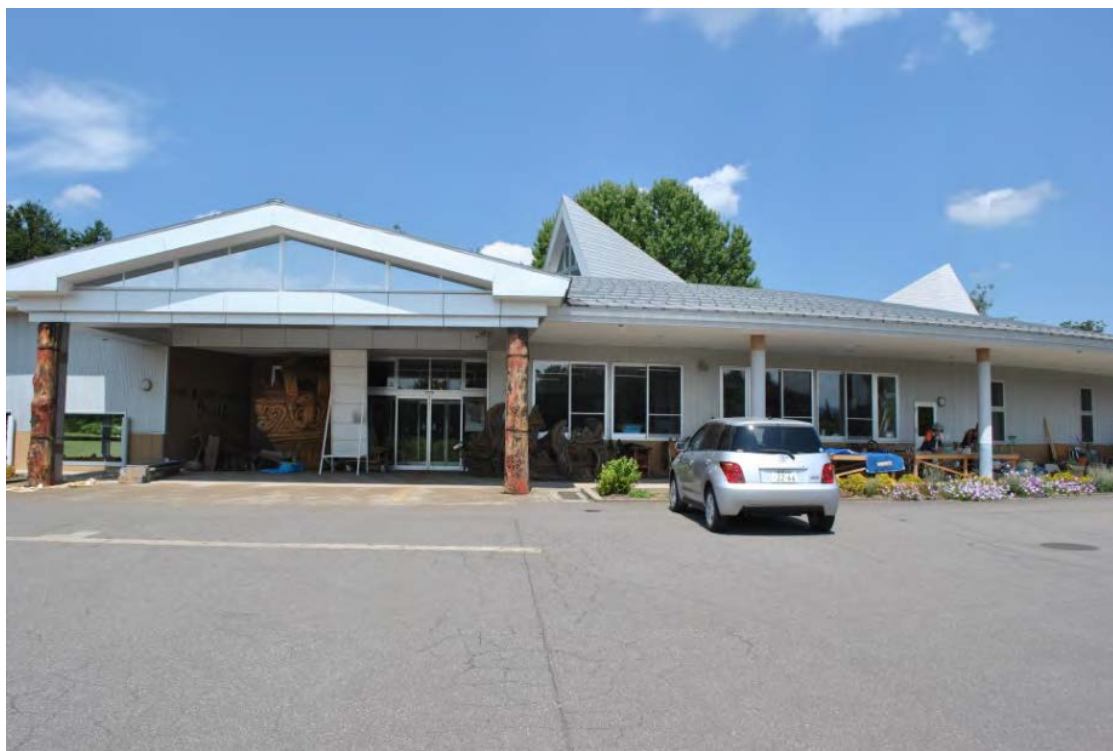
写真3: 農と縄文の体験実習館「なじよもん」施設 (2012年8月22日撮影)
