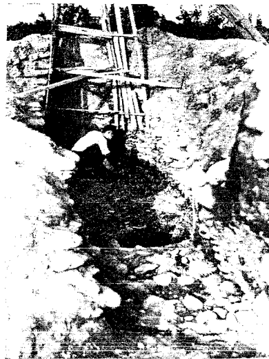
3 第1号墳石室(南西より)
